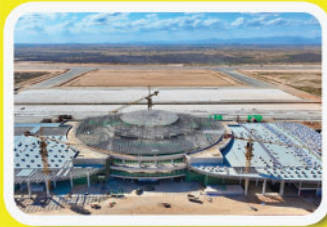
UJENZI WA VIWANJA VYA NDEGE
